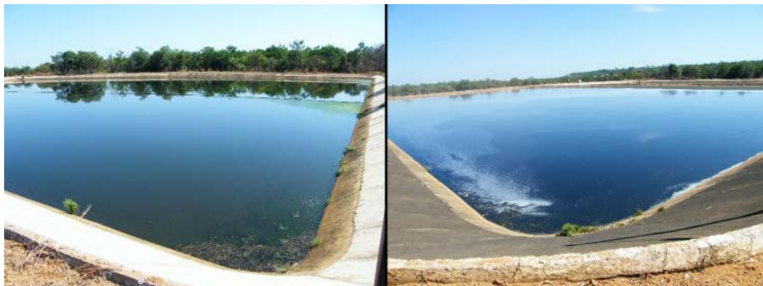
Figura 03: Lagoa anaeróbia da ETE Aureny
